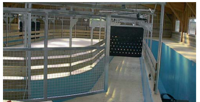
Marcheur Entreprise ovale 10 x 20 m, pour 6 chevaux, monté dans un manège existant. Haras de Sassy, St.-Christop (F)
