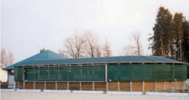
Marcheur Entreprise ovale 12 x 25 m, pour 9 chevaux, avec toiture de piste. Centre d'équitation am Buchenwald, Amtzell (D)
